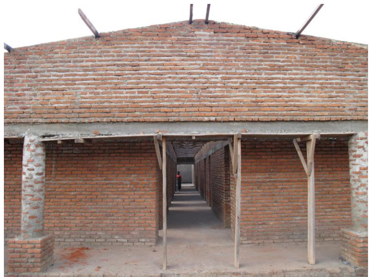
Residencia de Alumnas de la Escuela Primaria
