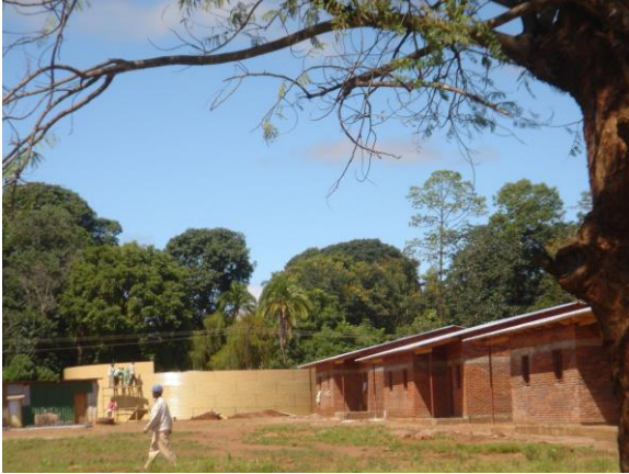
La escuela agrícola. Casas de los monitores
